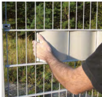
Taśma ogrodzeniowa montowana na panelach ogrodzeniowych.
